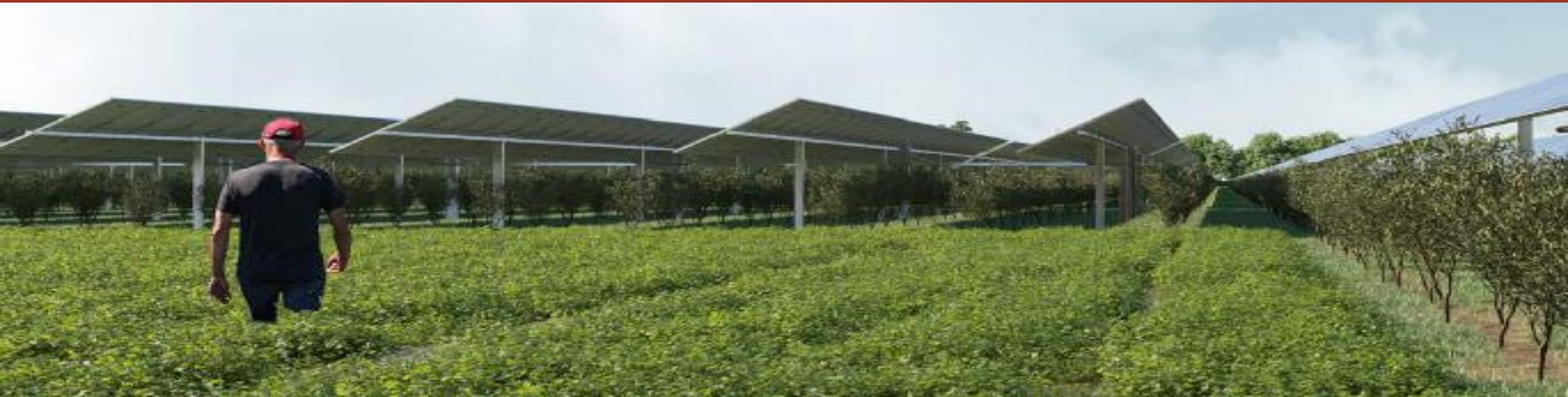
**Agrivoltaico consiste nell'uso della stessa area di terreno sia per l'energia solare fotovoltaica sia per l'agricoltura.**
